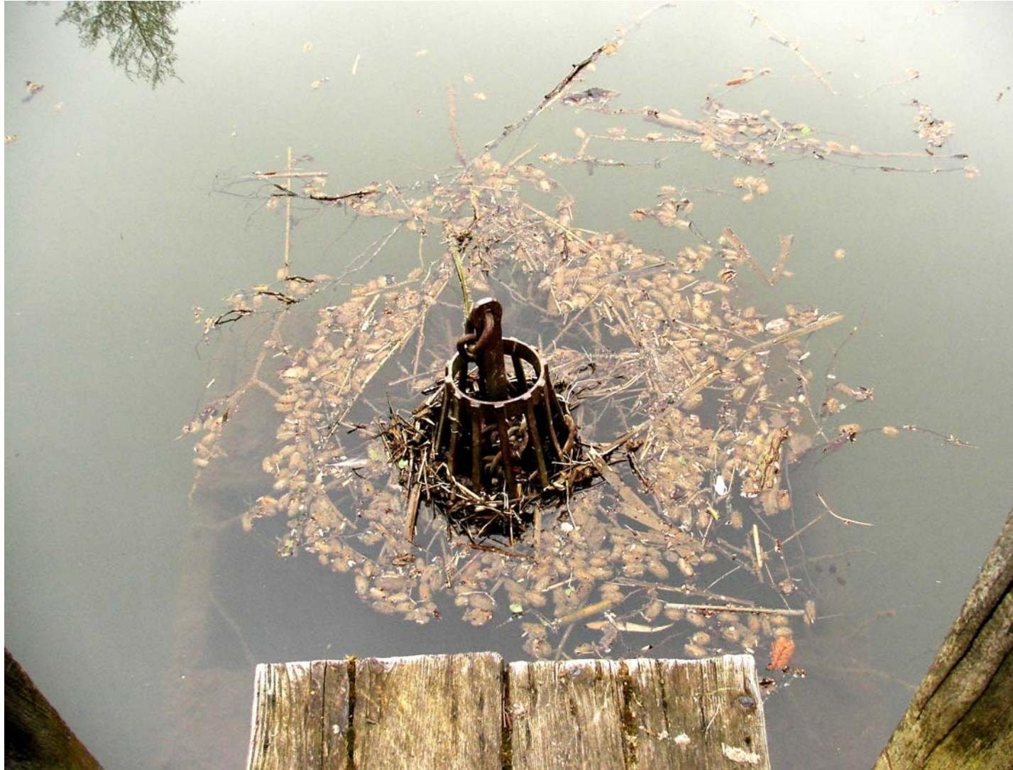
Der ungünstige Auslass, einerseits verstopft er leicht und der Wasserspiegel ändert ständig. Andererseits reisst er immer wieder Frösche und Kröten in das Ablaufrohr und somit in das etwa 30m entfernte Bächlein.
